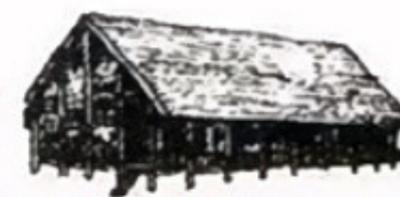
由桩、柱构架的干栏式建筑
