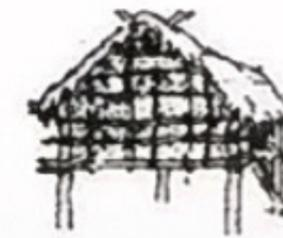
由桩、柱构架的干栏式建筑
